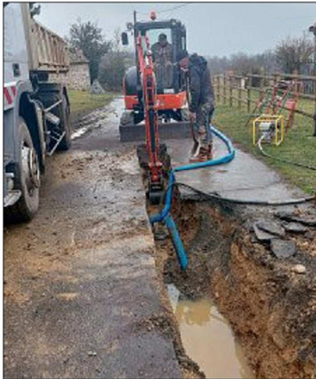
LA RODE. La dernière étape est la réparation de la fuite. Cela nécessite des engins de terrassement et une coupure d'eau pendant les travaux.
