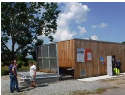
Visite de la chaufferie bois de Messeix
